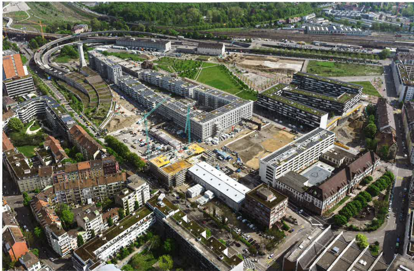
Bild: Bau- und Verkehrsdepartement des Kantons Basel-Stadt
