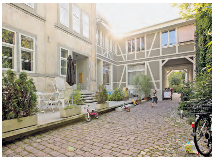
Reichensteinerstrasse 14. Der Bau stand lange leer, heute gehen hier Iris Becher, Stefan Fischer und die Töchter Muriel und Ricarda ein und aus (oben).
