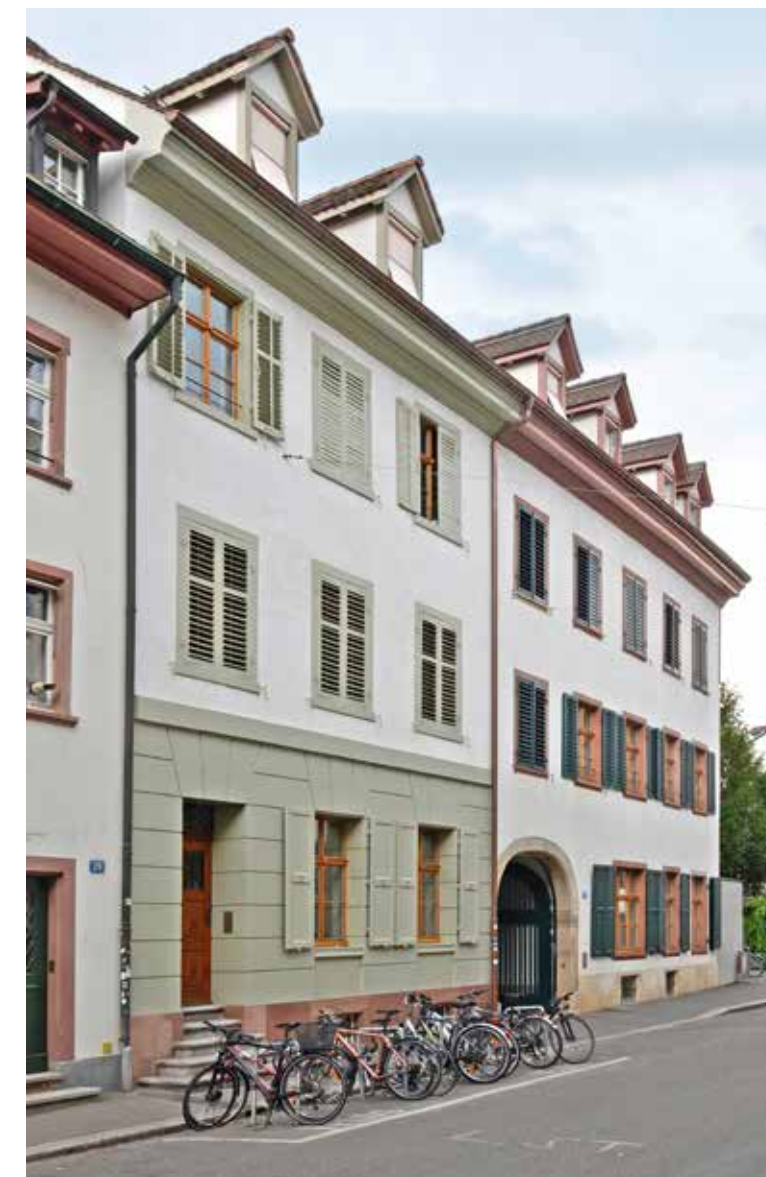
Der Gebäudekomplex der ehemaligen Lotz'schen Färberei gegen die Rheingasse nach Abschluss der Instandsetzungsarbeiten. Links das 1839 klassizistisch überformte Wohnhaus des Fabrikherrn (ehemaliger Unterlindenhof), rechts das 1855 aus zwei Häusern vereinigte Verwaltungsgebäude mit Durchfahrt von 1671.
