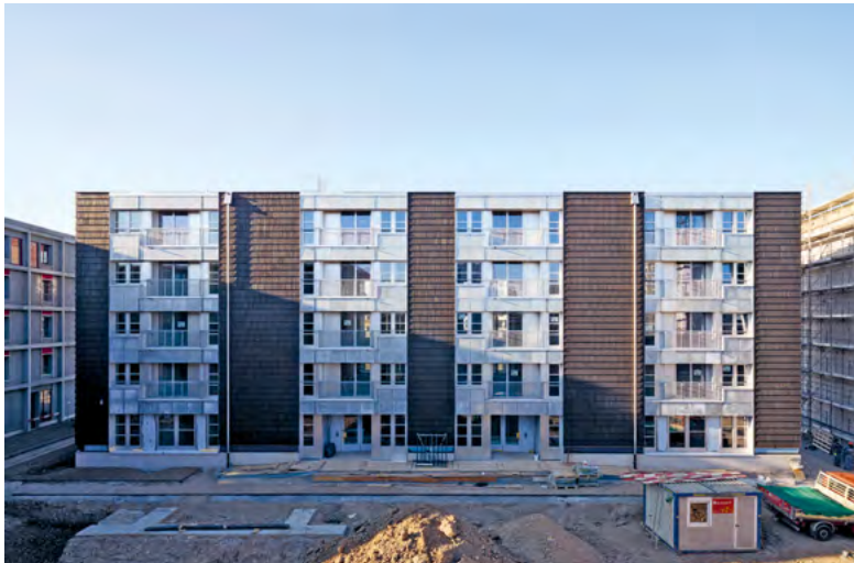
Wohnhaus Goldbachweg 20/22 kurz vor der Fertigstellung
