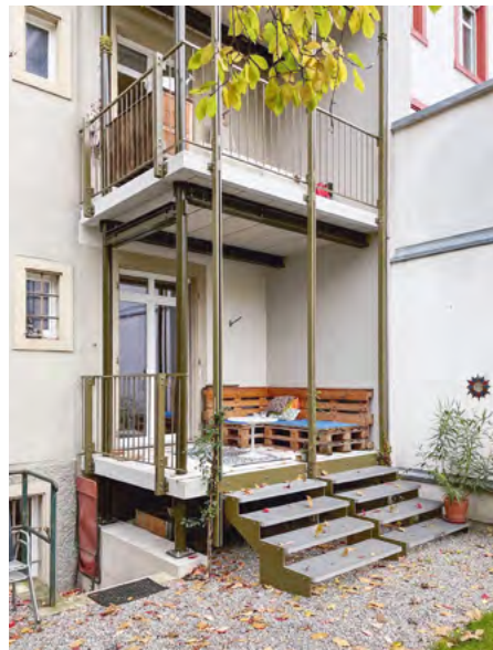
Ein gelungenes Ergebnis guter Teamarbeit an der Allschwilerstrasse 44
