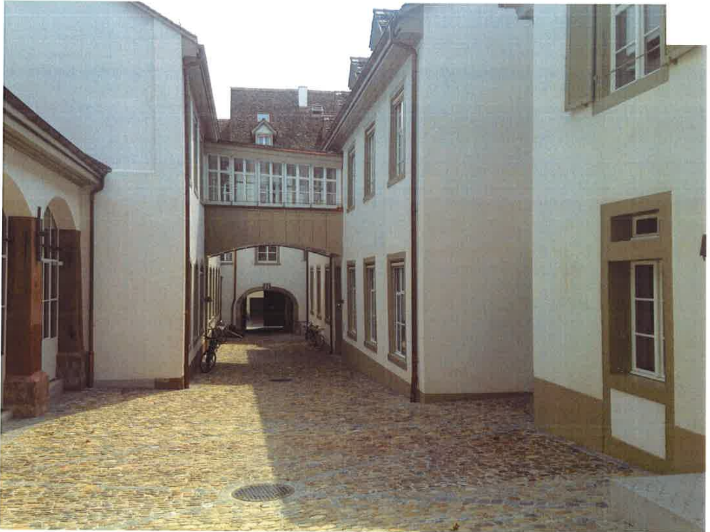
Die neu eröffnete Gasse, von der Utengasse her fotografiert. (Bild: Stiftung Habitat)
