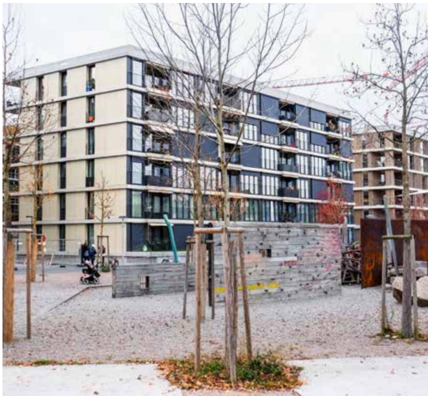
Auch das Haus der Sowag AG für sozialen Wohnungsbau ist auf die Anforderungen der 2000-Watt-Gesellschaft ausgerichtet. Während der Kern aus Beton besteht, sind die Aussenhüllen in einer mehrschichtigen Leichtbauweise ausgeführt. Treppen, Loggien, Balkone und Stützen wurden kostengünstig aus vorfabrizierten Elementen erstellt.
